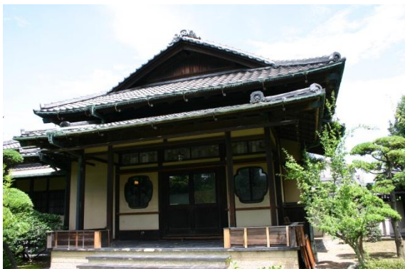
外観は瓦葺き入母屋造の棟を連ねる書院造の系統を引く諸建物で構成されている純和風建築。
