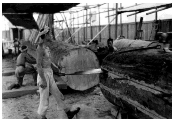
樟徳館建築のために作られた専用の製材所での作業風景
